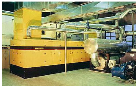
带有机舱的具有较大功率输出的热电联供设备
